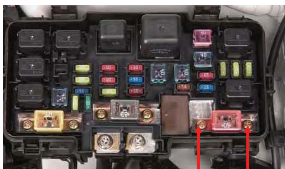
Tampa da caixa de fusíveis
