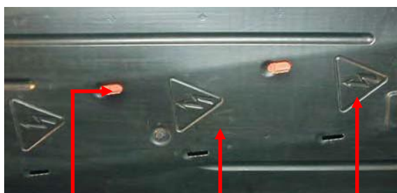
Widoczny przewód wysokiego napięcia
