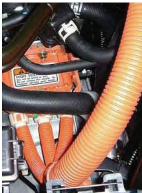
HV-kabelverbinding naar de verbrandingsmotor
