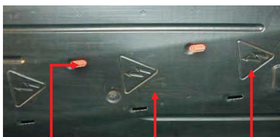
Cavo alta tensione visibile
