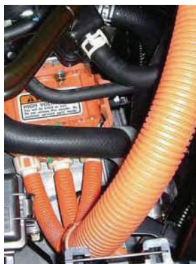
Collegamento cavi alta tensione al motore elettrico
