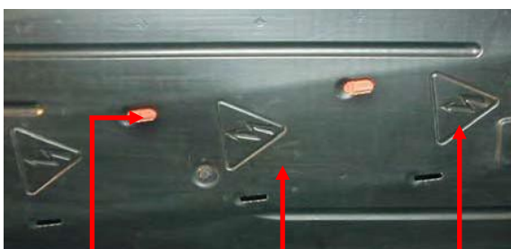
Látható nagyfeszültségű kábelek
