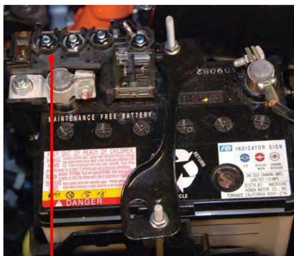
DC-DC- muuntimen johto
