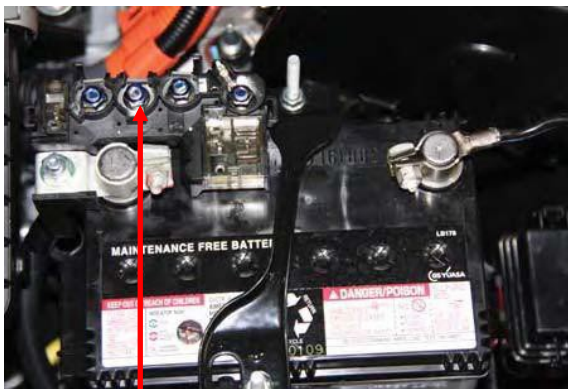
Σύνδεση καλωδίων μετατροπέα ΣΡ σε ΣΡ
