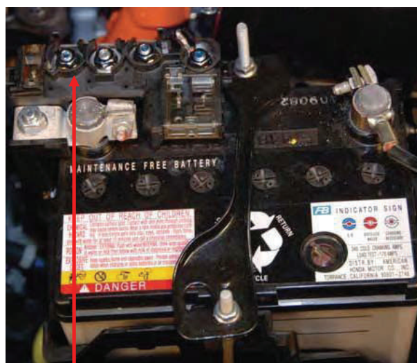
Kabel měniče DC/DC
