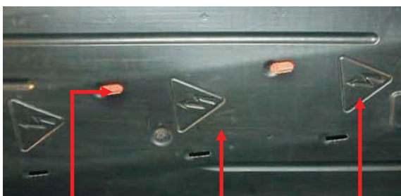
Viditelný vysokonapěťový kabel
