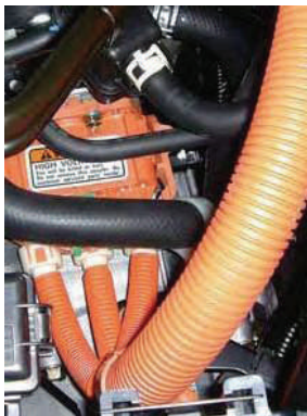
Připojení vysokonapěťového kabelu k elektrickému motoru
